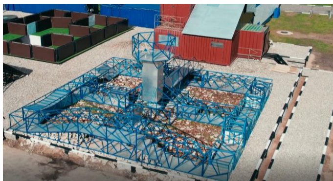
Рисунок 6 – Тренажер «Диггер» для подготовки пожарных и спасателей к одиночному и групповому перемещению пожарных и спасателей в условиях ограниченного пространства и видимости / Figure 6 – Digger simulator for preparing firefighters and rescuers for single and group movement of firefighters and rescuers in conditions of limited space and visibility
